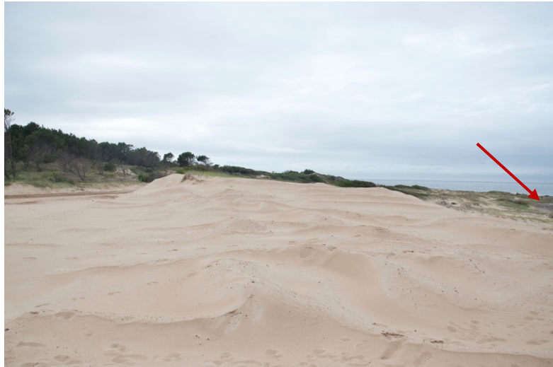
Figura 7. Zona de movilización de arena y aplanamiento de superficie en cordón dunar dentro de la faja de defensa costera. Se observa material grueso (balastro) en la parte superficial en las zonas trabajadas con la maquinaria. La flecha roja indica la ubicación del sitio arqueológico G29-043 en Punta Negra, a unos 90 metros del área de obras.
