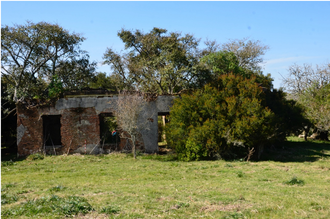
Figura 9. Tapera de ladrillo y piedra establecida sobre una estructura monticular en tierra. Casco de estancia abandonado. Archivo LAPPU, 2019.
