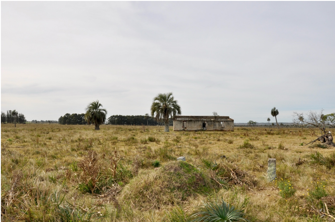
Figura 51. Vista de Portera Negra. Archivo LAPPU 2022.
