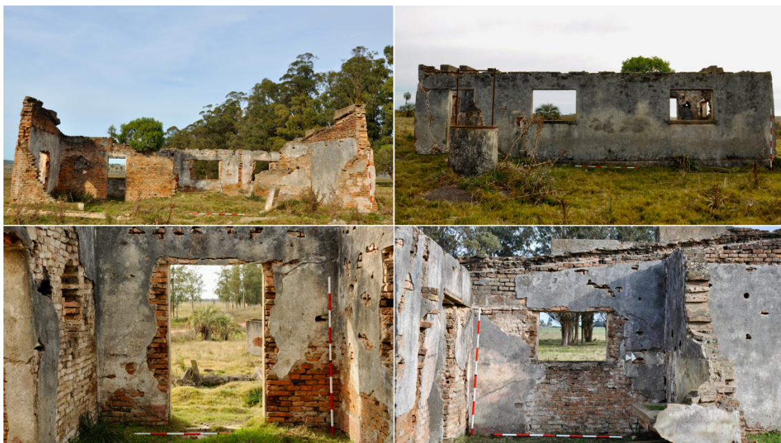
Figura 54. Vista exterior e interior del Almacén San Cono. Archivo LAPPU 2022.
