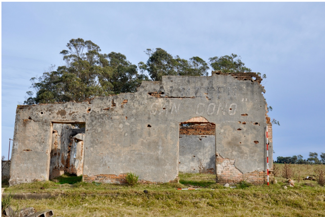
Figura 53. Vista del Almacén San Cono, ubicado sobre el camino de entrada a Portera Negra. Archivo LAPPU 2022.
