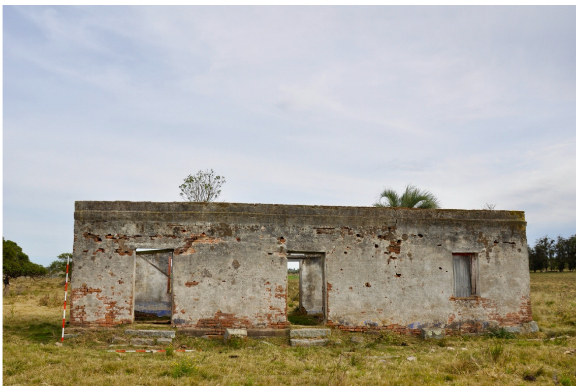
Figura 55. Estructura de almacén en Portera Negra. Archivo LAPPU 2022.
